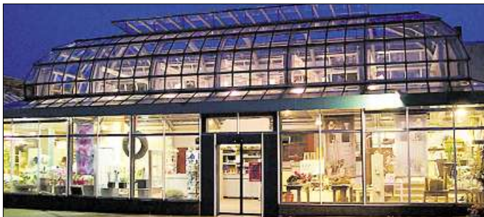
Wird im Herbst im Essgarten in Winkelsett aufgebaut: das Gärtnerereignisgebäude aus Gifhorn. BILD: PRIVAT
